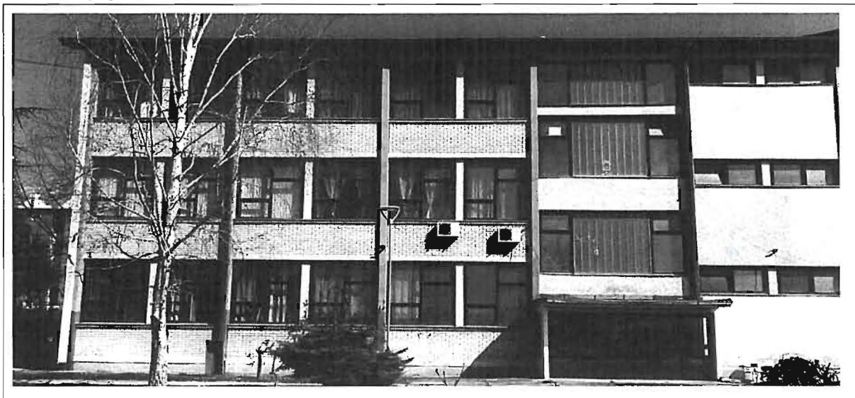
Фотографије фасада објекта бр. 2 – нова школа
