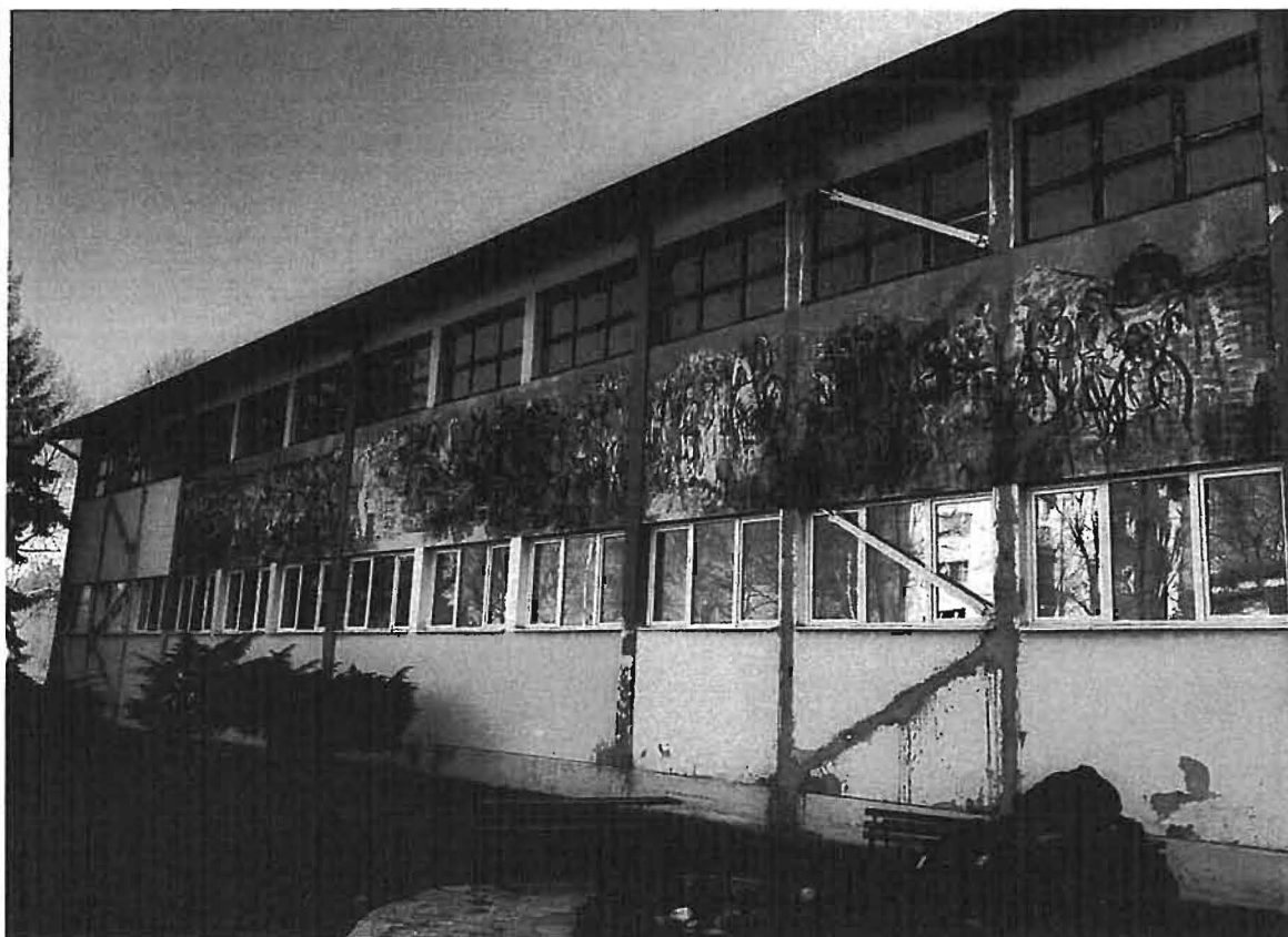
Фотографије фасада објекта бр. 1 – стара школа
