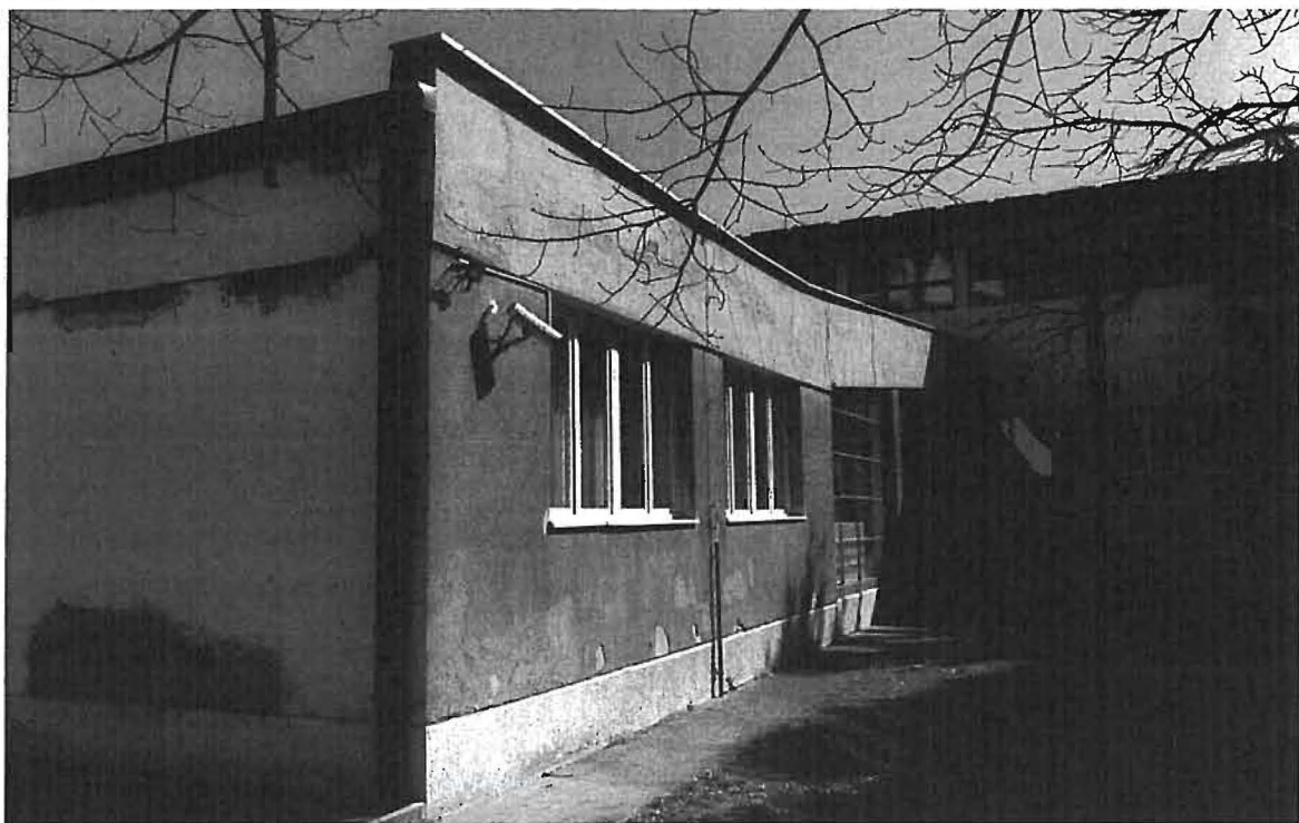
Фотографије фасада објекта бр. 1 – стара школа
