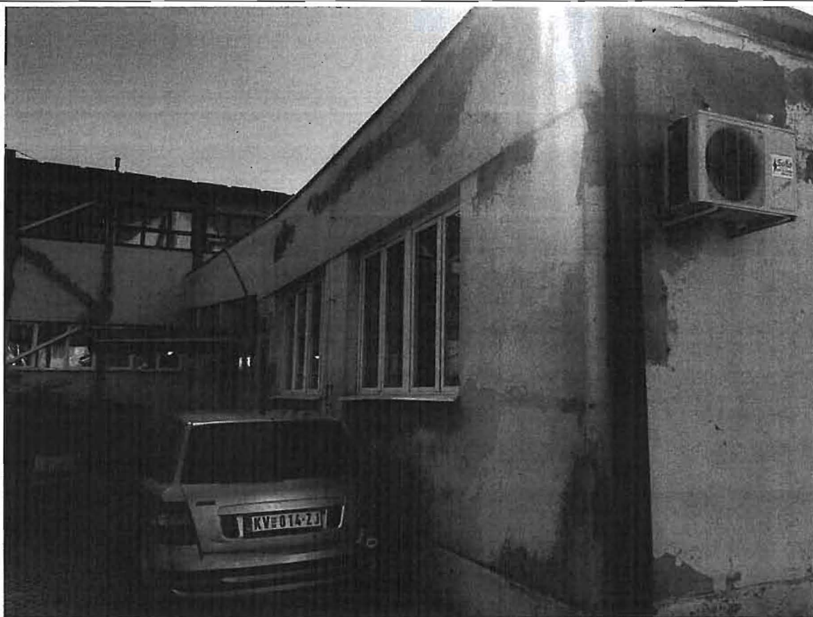
Фотографије фасада објекта бр. 1 – стара школа
