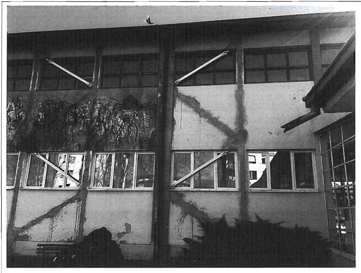
Фотографије фасада објекта бр. 1 – стара школа
